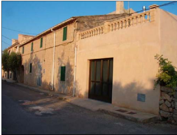
FAÇANA A CARRER DES TORRENT
