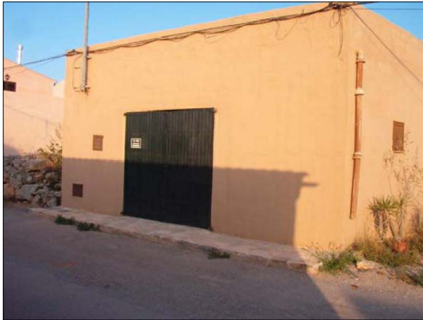
FAÇANA A CARRER DES TORRENT
