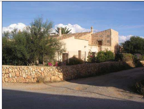
FAÇANA A CARRER
