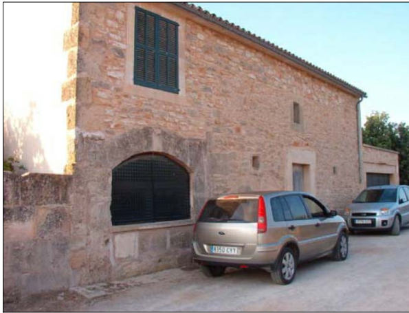
FAÇANA A CARRER
