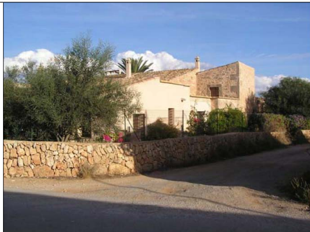
FAÇANA A CARRER
