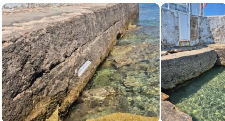
Ilustración: socavación y mal estado del muro. Será necesario reforzar con algo de escollera este tramo.
