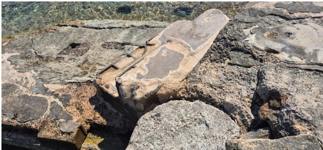
Ilustración 12: reparaciones importantes tanto de cimentación o refuerzo del muro como de su paramento y del pavimento.
