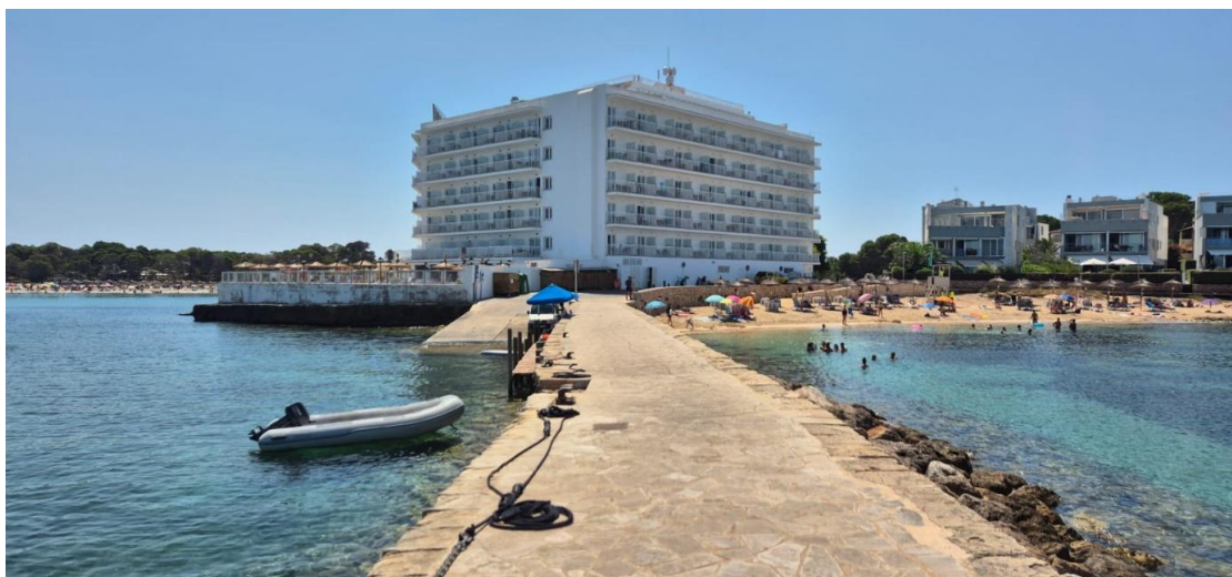
Ilustración 5: mismo pavimento, en este caso empleado en la reconstrucción del muelle, antiguo "Carregador de sal".
