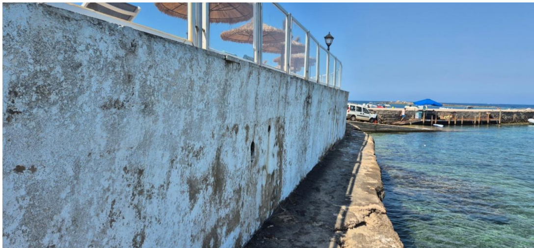
Il·lustració 10 además del muro, será necesario sustituir el pavimento con un pavimento de piedra con algún elemento de borde.
